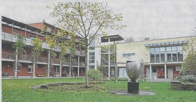
Der Innenhof des Wohnprojekts in Dortmund – links die Wohnungen, rechts die Gemeinschaftsräume inklusive Gästewohnung und Waschküche
